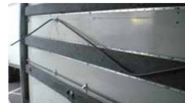
↻ Polsterung und Stangen: Stangen, Befestigungen, Polster fehlen oder sind verformt, können nicht auf wirtschaftliche Weise repariert werden
