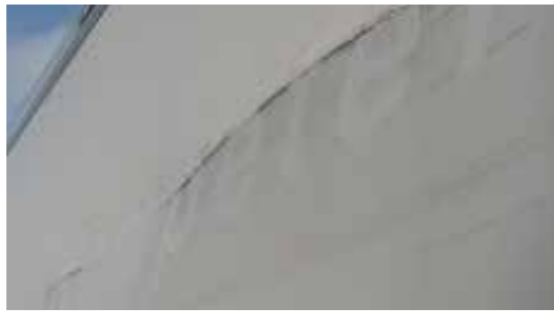
↻ GFK-Seitenverkleidungen: Verformung am Unterteil, Länge > 1 m Bitte beachten: Der Austausch der vorderen Tafel des Unterbodens erfordert den Ausbau des Unterbodens.
